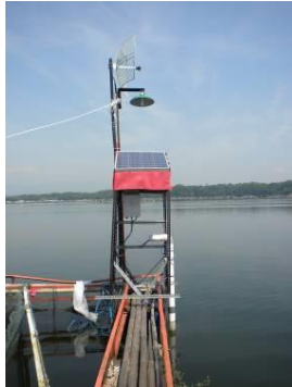
Gambar 4. Pemasangan Stasiun Pengukuran di KJA.
